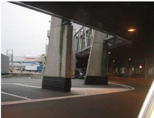
Fig. 6. De Schiphol-rondweg loopt gedeeltelijk onder de pieren zoals hier. Hoewel er amper directe zichtlijnen zijn naar de GPS-satellieten is hier toch plaatsbepaling mogelijk met een hogegevoeligheids-GPS-ontvanger.
